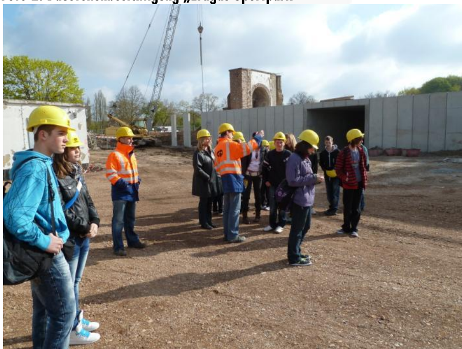
Foto 2: Baustellenbesichtigung „Erdgas Sportpark“
