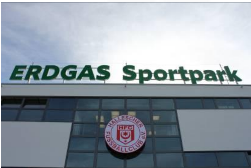
Foto 2: Funktionsgebäude des ERDGAS Sportparks
