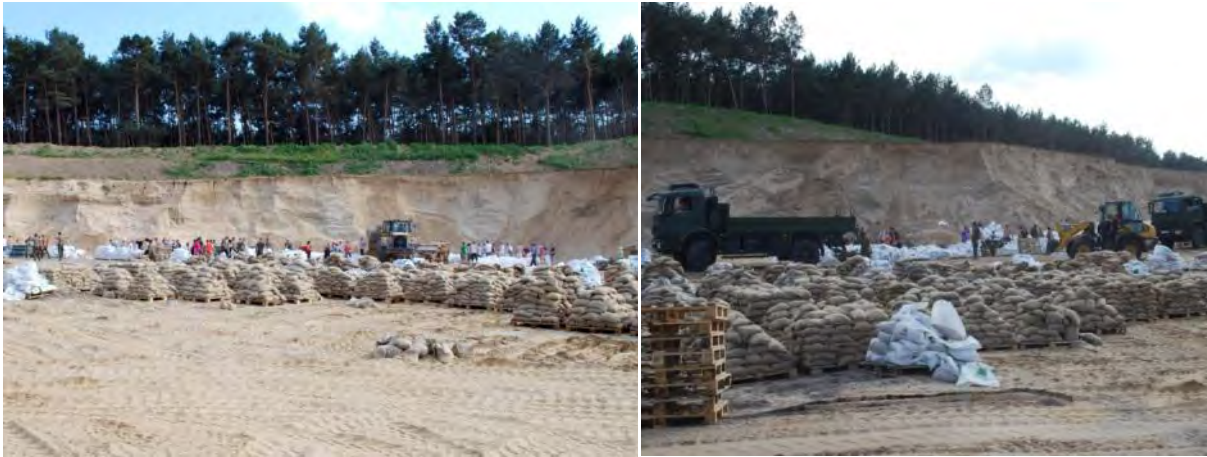
Sandsackbefüllung am Unternehmensstandort in Farsleben
